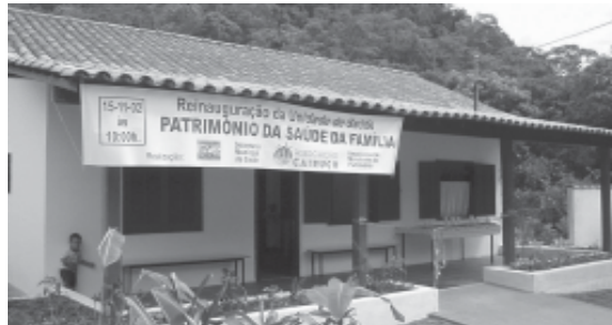
Módulo ESF - unidade reformada do Patrimônio
